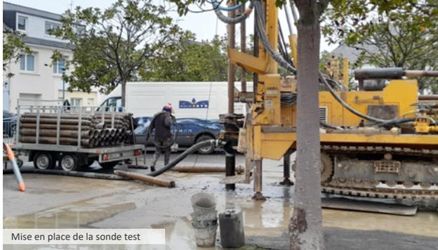
Mise en place de la sonde test
